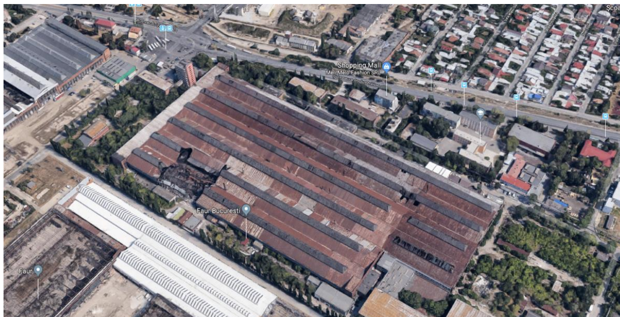
Figura 1. Observație a planului inițial al viitorului centru social și de agrement Hala Laminor (Google Maps – Ianuarie 2018)
